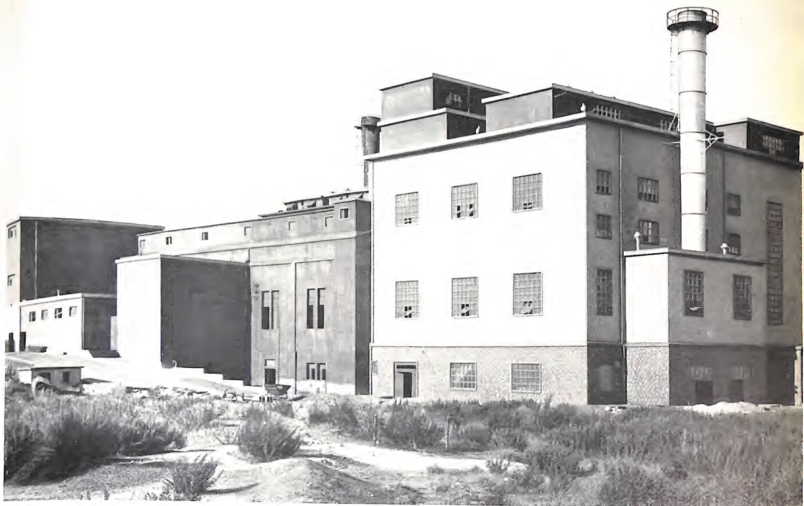
Centrale di Porto Vesme - Da Sud-Ovest.
